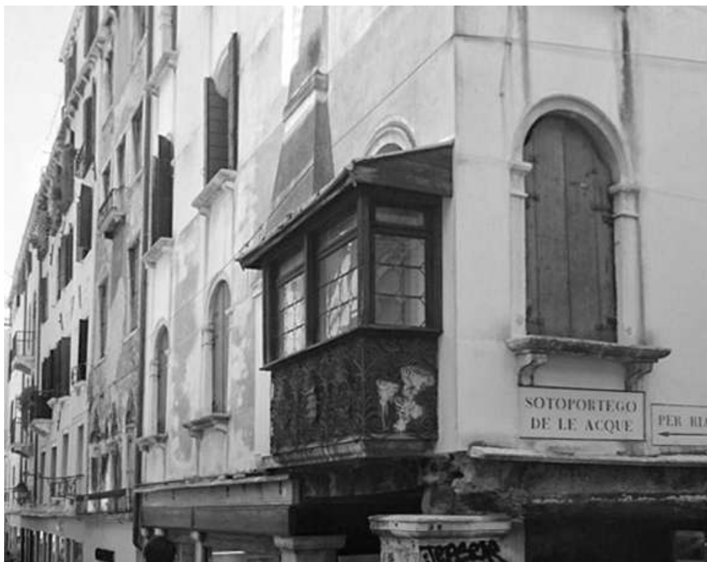
Figura 2 Tipica struttura detta Liagò, Venezia. Fonte: archivio dell'autore.
